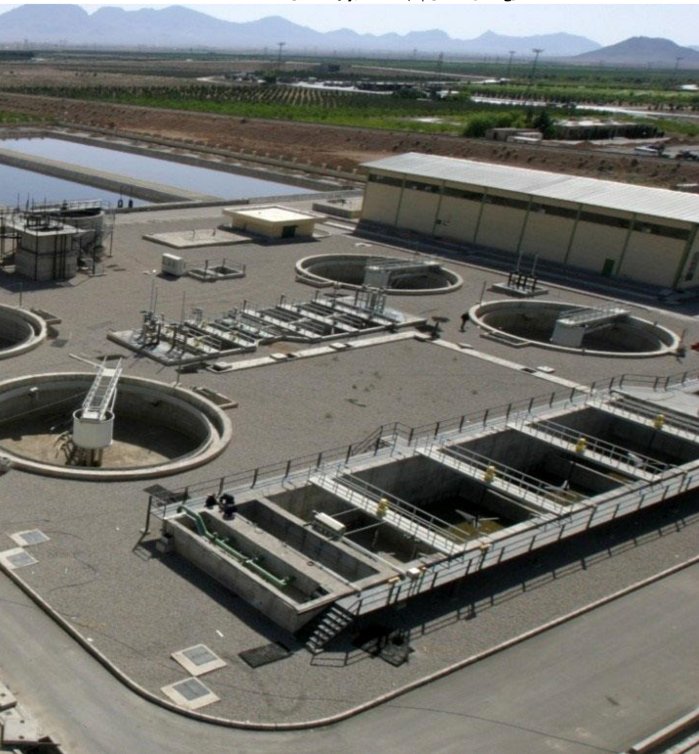
نمایی از تصفیه خانه های پساب در دست اجرا و راه اندازی شده
