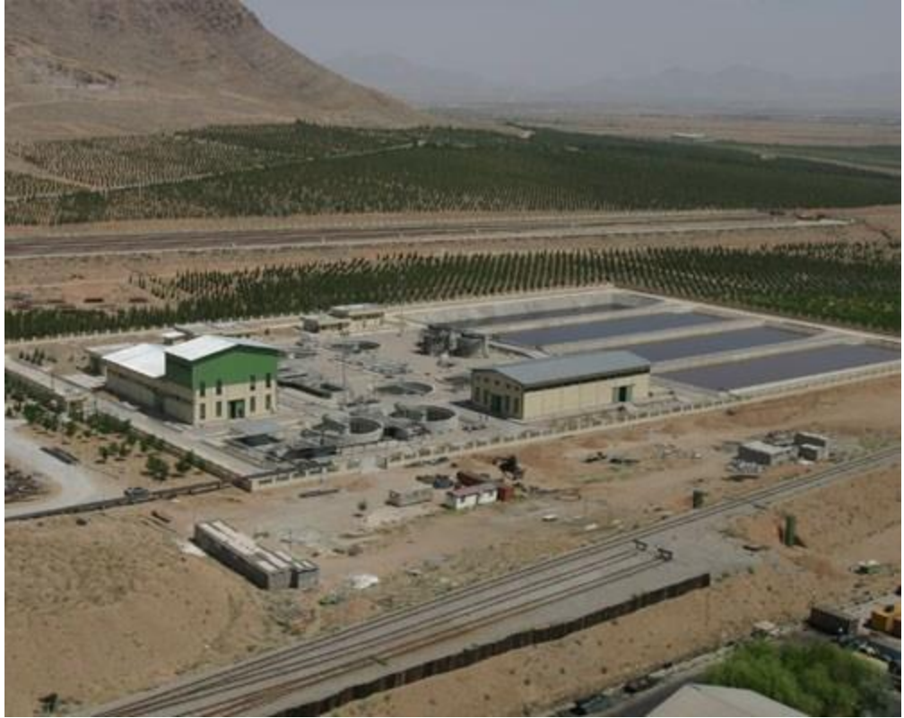
شکل ۸: نمایی از تجهیزات تصفیه خانه پساب در فولاد مبارکه
